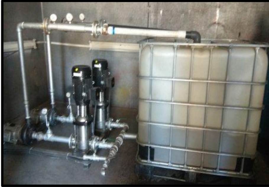
Figura 1. Reactor CAVOXD que induce cavitación hidrodinámica, desarrollado por la empresa AC AND DC ENERGY para el tratamiento de aguas residuales. (Imagen con permiso de AC and DC Energy).
