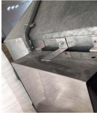
Figura A-11 Carcasa de protección de control de la lámpara.
