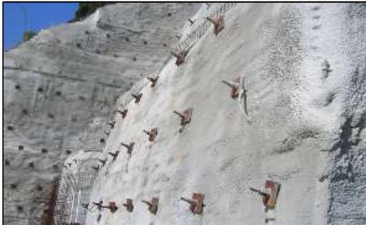
**Figura 28.** Malla metálica
