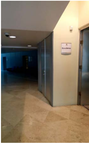
Figura 4: Las escaleras tienen que ser anunciadas con un rótulo debido a la poco pertinente solución arquitectónica
