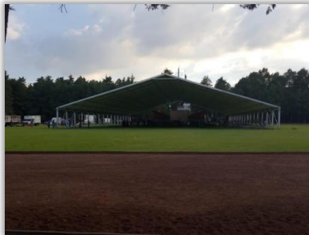
Imagen 9. Zona de usos especiales
