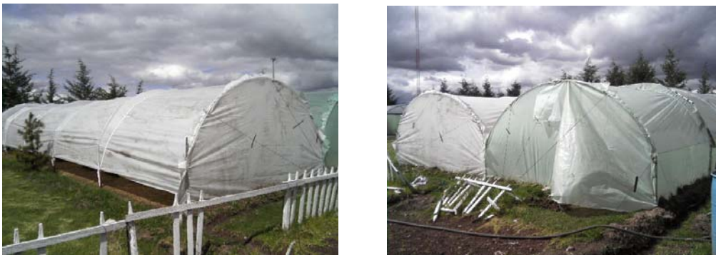
Figura 3. Construcción de cubierta plástica
