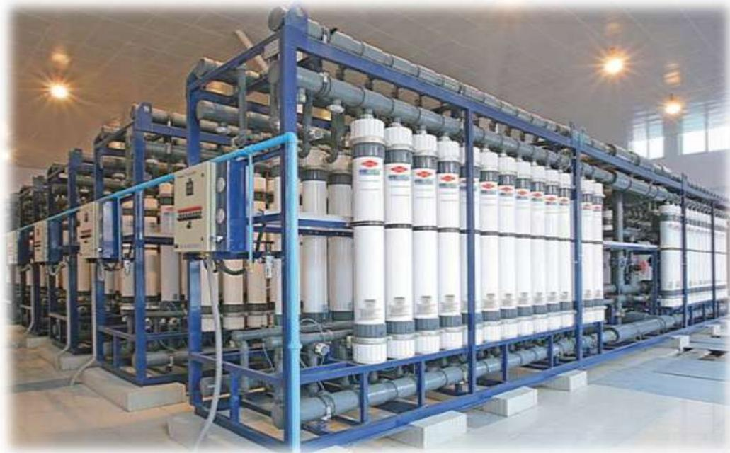
Figura 4. Ultrafiltración
