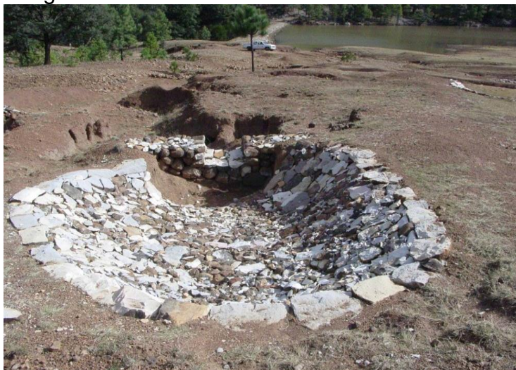
Figura 4.4.1: Relleno del cabeceo de la cárcava
