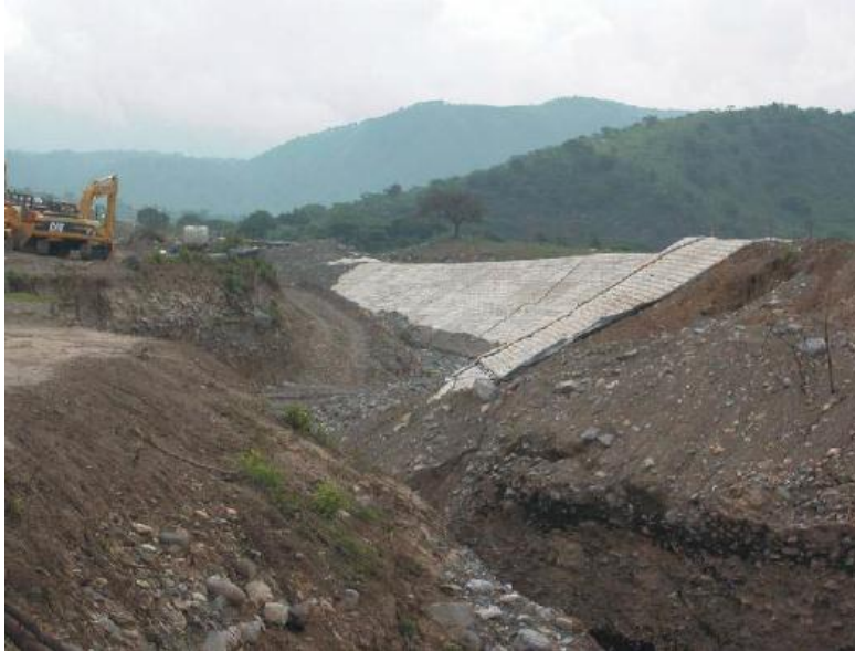
Figura 4.4.5: Geotextil en los taludes de la cárcava
