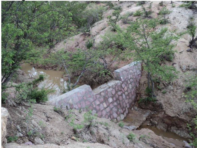
Figura 4.4.4: Presa de mampostería hidráulica
