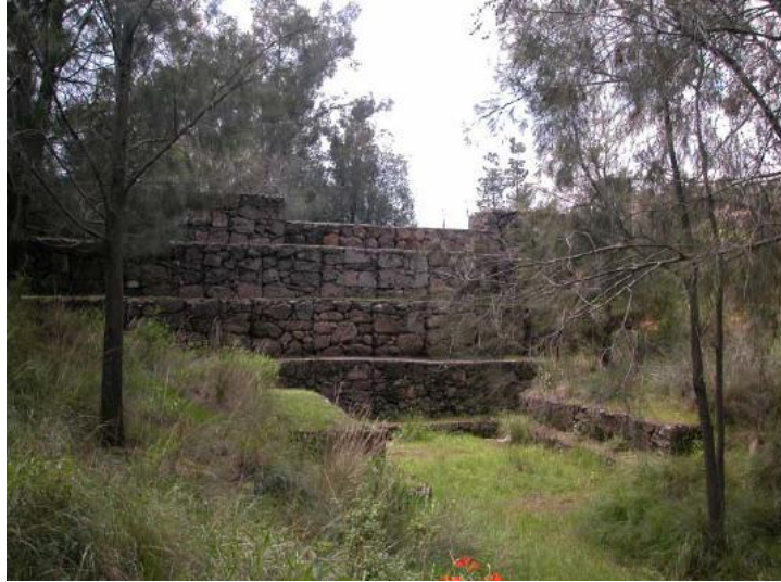
Figura 4.4.3: Presas de gaviones
