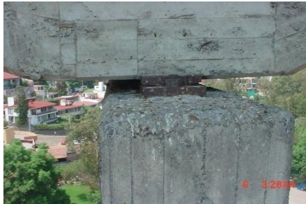
(b) Placas metálicas
