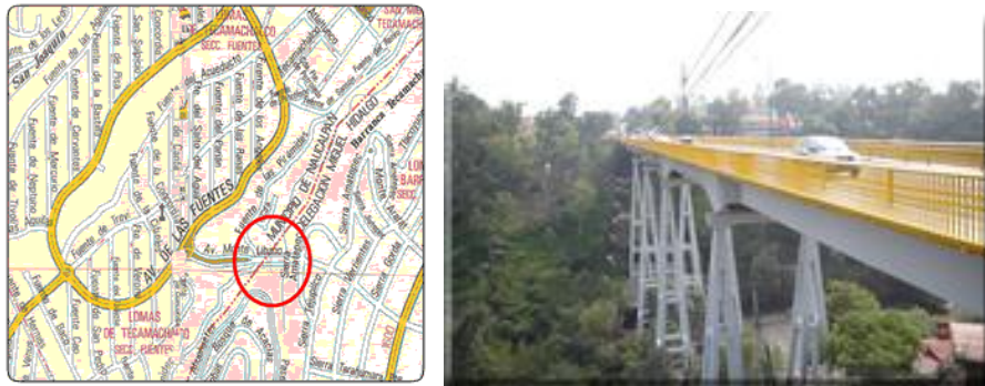
Figura 4.1 Ubicación del Puente Vehicular Monte Líbano
