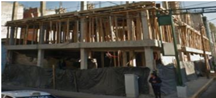
Figura 3. Planta baja terminada
