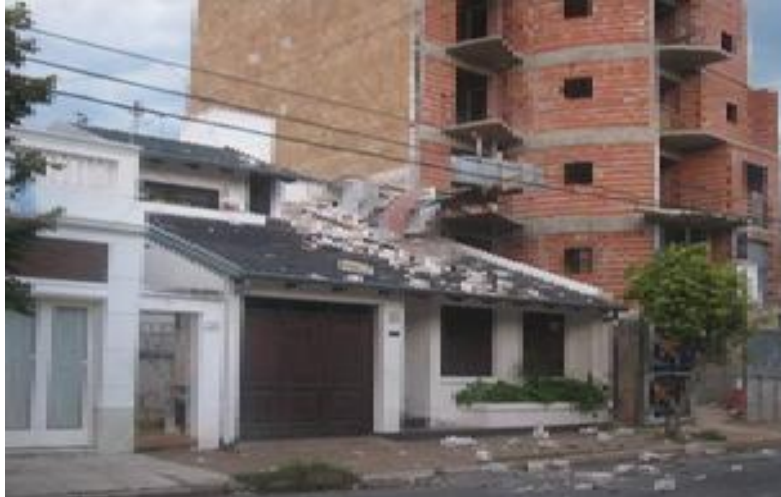
Figura 5. Daños o deterioros por descuido o falta de protección. Derrumbe de barda sobre casa colindante, problemas técnicos
