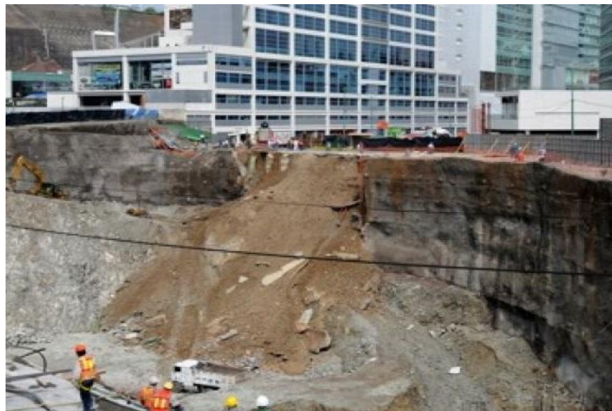
Figura 5. Daños o deterioros por descuido o falta de protección. Derrumbe de barda sobre casa colindante, problemas técnicos
