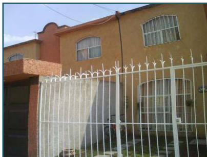
Figura 4.7 Modificaciones realizadas en algunas casas de “Paseos del Valle” para incrementar sus niveles de seguridad
