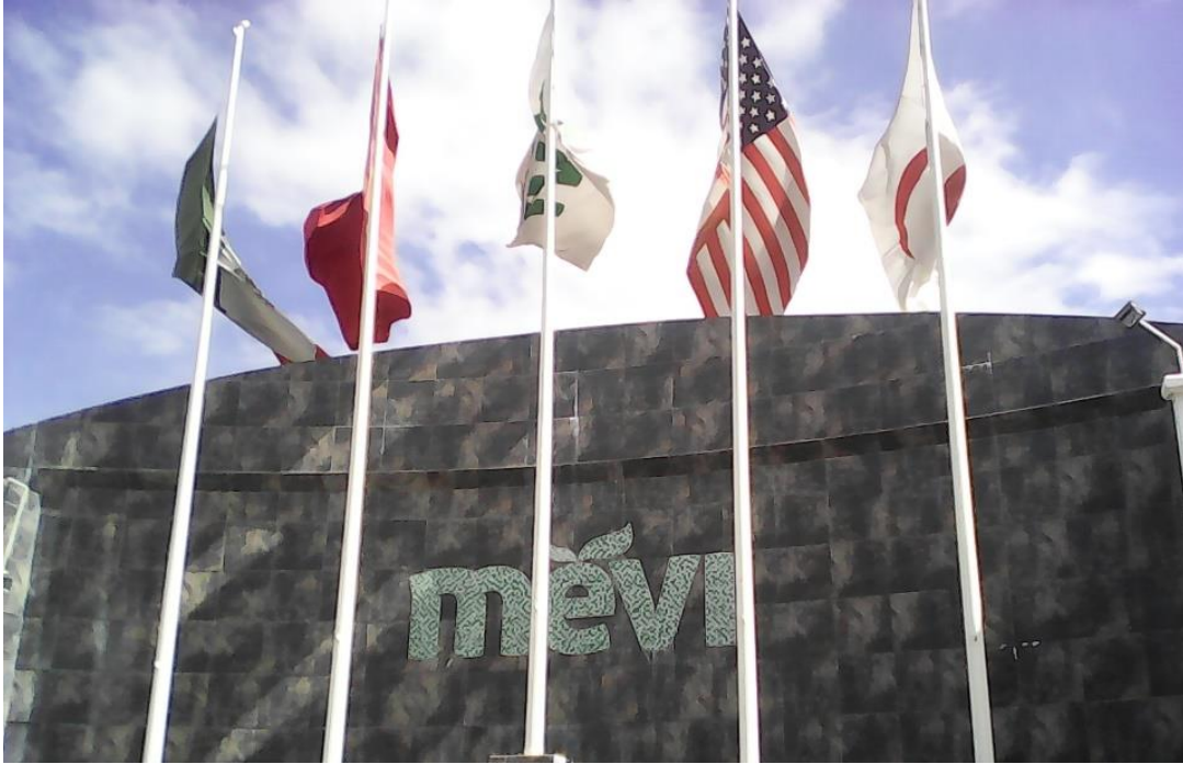
Figura 10. Empacadora Mevi Aguacates de Calidad S.A. de C.V.
