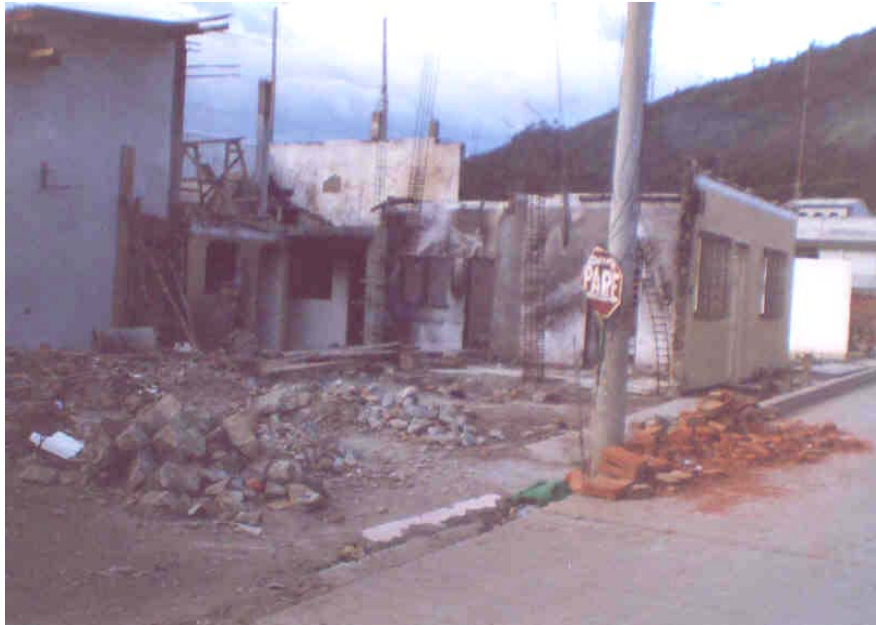
Vivienda destruida por un cilindro de gas LP disparado desde un reducto en la montaña por miembros de las FARC.
