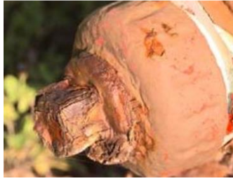
Figura 7. Corrosión por exfoliación.
