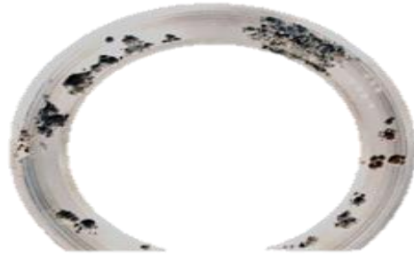
Figura 6. Corrosión por picaduras.
