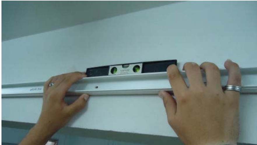
Ilustración 27: Instalación de canaletas y salidas del cableado. Fuente: Creación propia.
