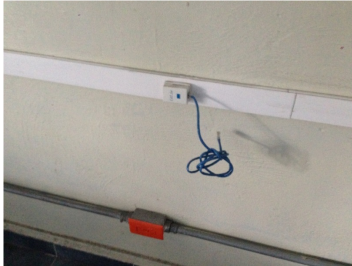
Ilustración 30: Instalación de cable Ethernet en la canaleta y listo para conectarse a los equipos de cómputo. Fuente: Creación propia
