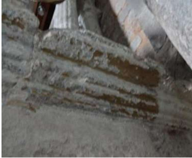
Figura 81. Detalle de cornisa, rastro de pintura. Fotografía tomada por SCG el día 02/03/15.
