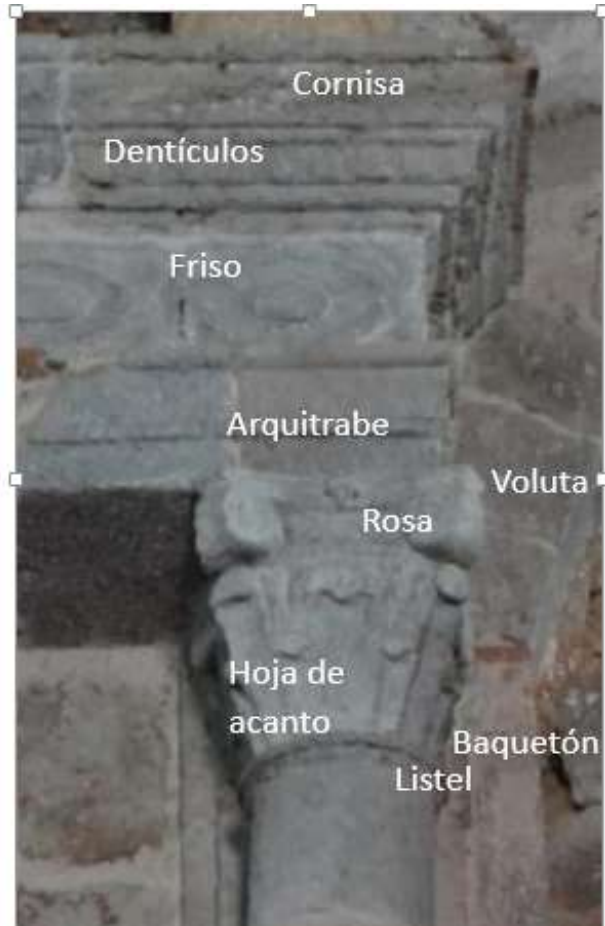
Figura 38. Fotografía de capitel y cornisamento, retablo de San Francisco, tomada por SCG. El día 14/09/13.
