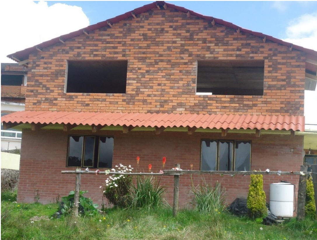
Fotografía 2: Fachada de vivienda al borde de carretera.
