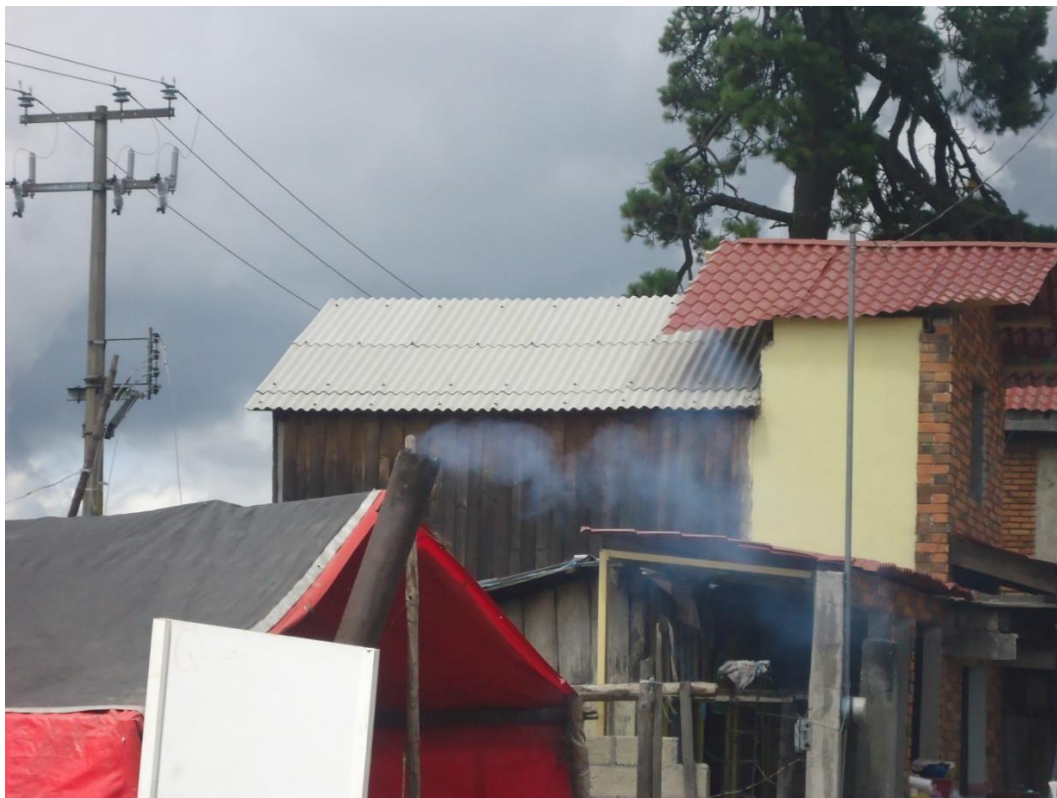
Fotografía 3: Vivienda con tres tipos de materiales de construcción.
