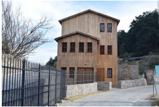
Figura 12. Socavón San Juan. (2019). Fuente: A.El
