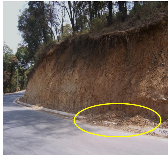
Figura 5 El corte en el terreno dejó las raíces al descubierto y el suelo a comenzado a desprenderse.
