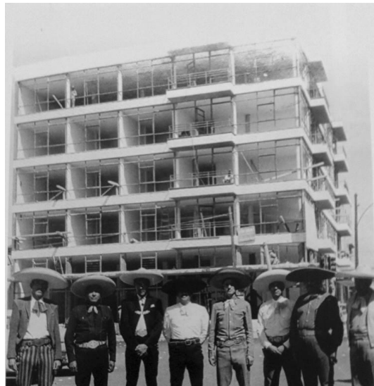
Imagen 7. Edificio Garcés en construcción.
