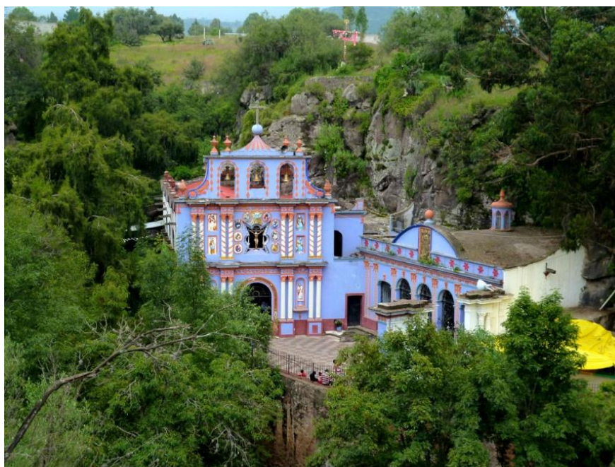
Imagen 6 - Fachada de la Capilla del Señor de la presa
