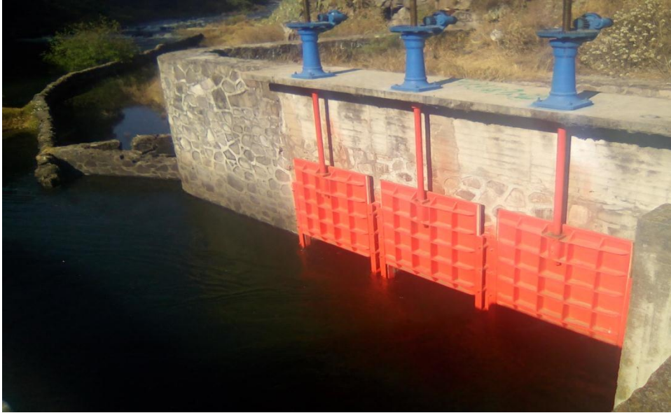
Foto 4: Compuertas del canal pincipal
