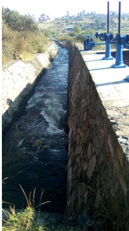
Foto 9: Canal principal de la presa Tepetitlán
