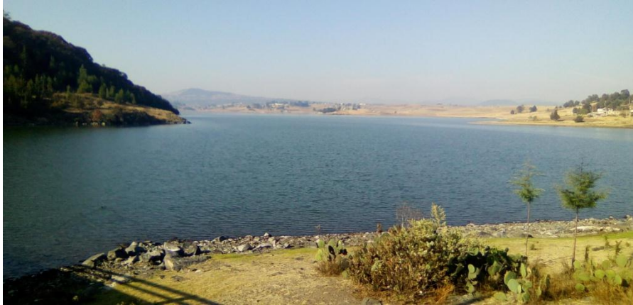
Foto 8: Vista de la presa desde la cortina
