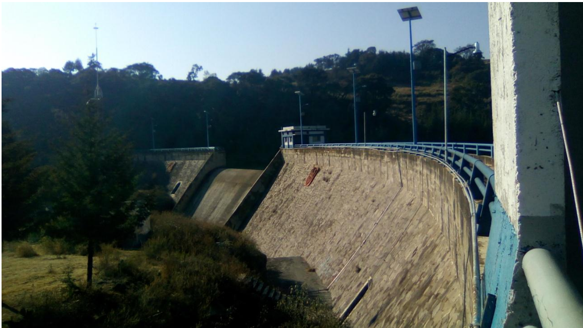
Foto 12: Vista lateral de la cortina de la presa.
