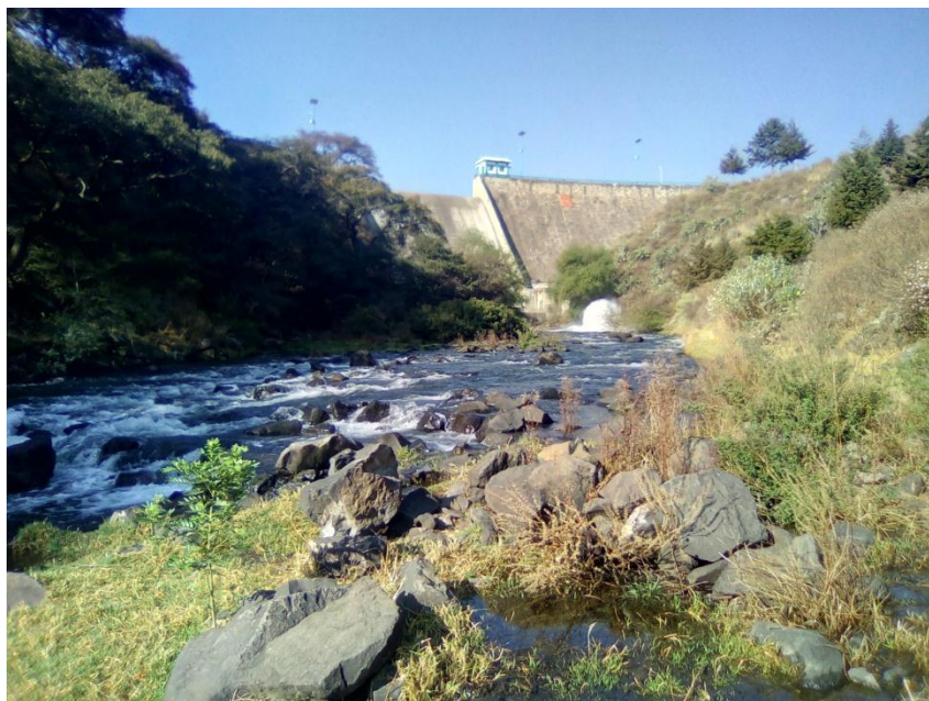
Foto 13: Vista de la cortina de la presa desde la desembocadura
