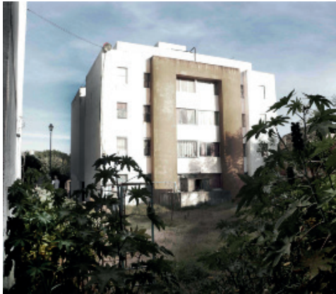
Figura 4. Estado final del área intervenida, autores del proyecto.
