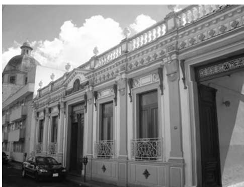
Casa entresolada. Se observan las ventilas bajo los balcones-ventana. Calle de Plutarco González 107-Toluca.
