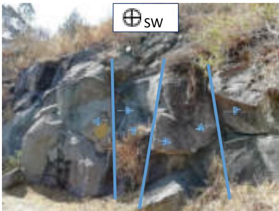
Figura 3.48 Conjunto de fracturas en afloramiento de macizo rocoso.
