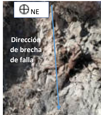
Figura 3.27 Brecha de falla en flujo andesítico.
