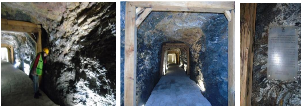
Imagen 2. Socavón San Juan
