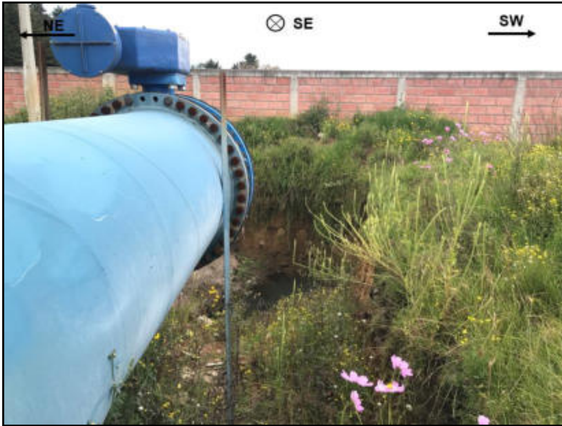
Figura 4.25 Arenas gruesas y limos color pardo-café con clastos de roca volcánica erráticos de tipo andesítica, espesor aproximado; 3 metros. En la parte derecha de la figura, se observa un tubo del sistema Cutzamala.
