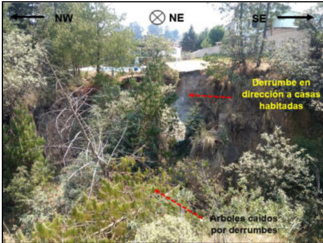
Figura 5.6 Cañada con derrumbes por proceso de erosión remontante, abriéndose paso hacia patios y jardines de casa-habitación.
