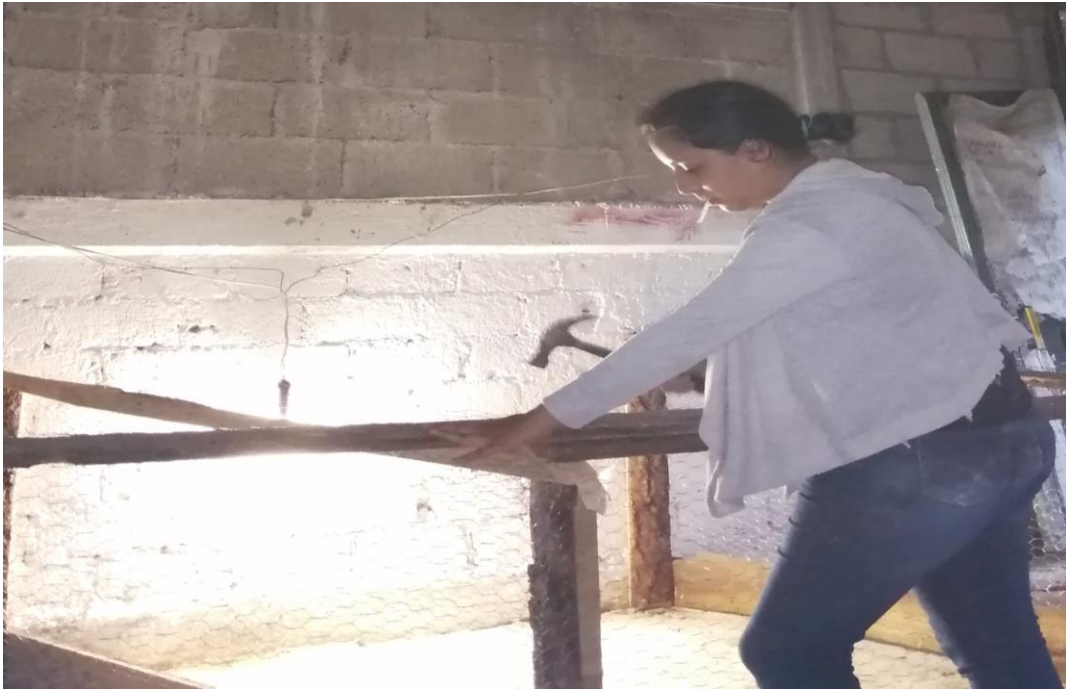
Ilustración 30 Colocación de la malla
