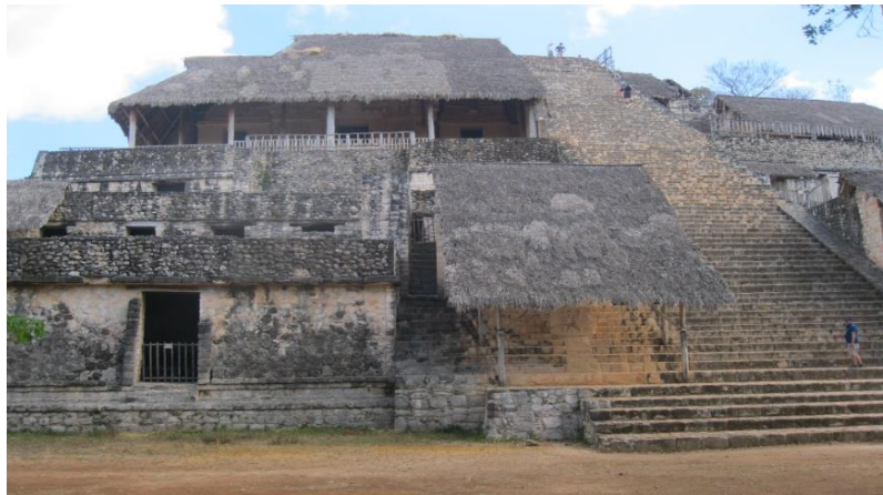
Imagen 1. Vista frontal del monumento "Acrópolis". En esta imagen se puede observar algunos cuartos en donde se encuentran resguardadas esculturas de Chaac.
