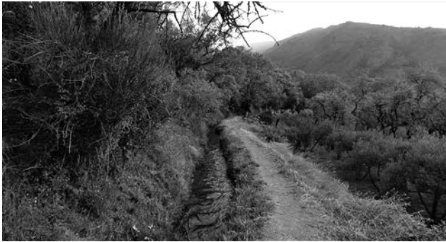
Figura 14. Canal o zanja que conduce agua a terrenos, también se utiliza para el llenado de bordos
