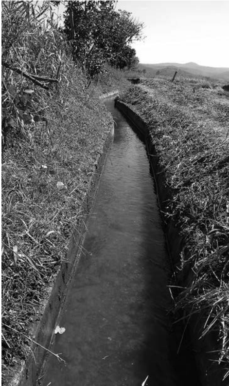
Figura 13. Dimensiones del canal por el cual el agua del río Calderón se dirige a los bordos
