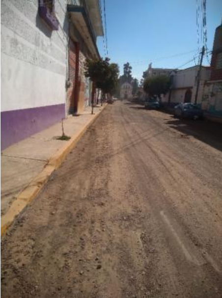
Figura 1: Calle no pavimentada
