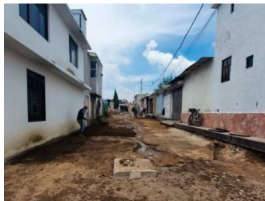
Figura 4.33: Pavimentación de calle
