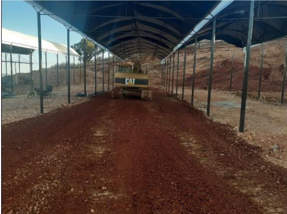
Imagen 24. Construcción de naves acondicionadas para tráileres en la Nueva Central de Abasto Villa Guerrero (Nueva Central de Abasto Villa Guerrero, 3 marzo, 2020).
