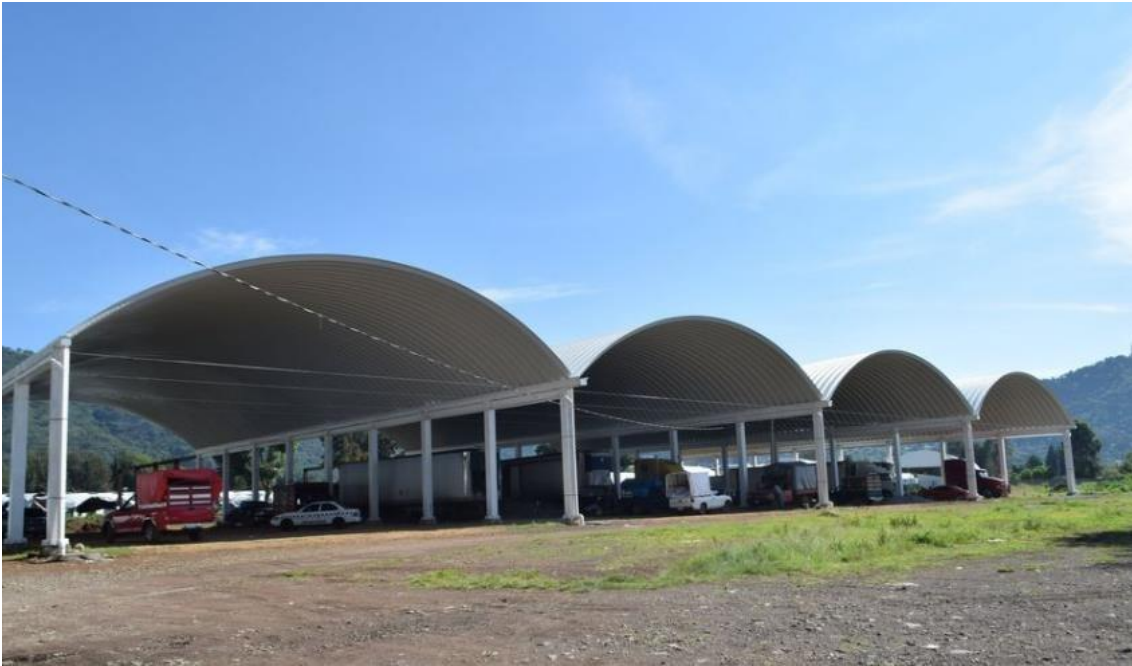
Imagen 15. Entrega de obra de arcotecho en el mercado regional de flores de Santa Ana Ixtlahuatzingo (Gobierno de Tenancingo, 2019).
