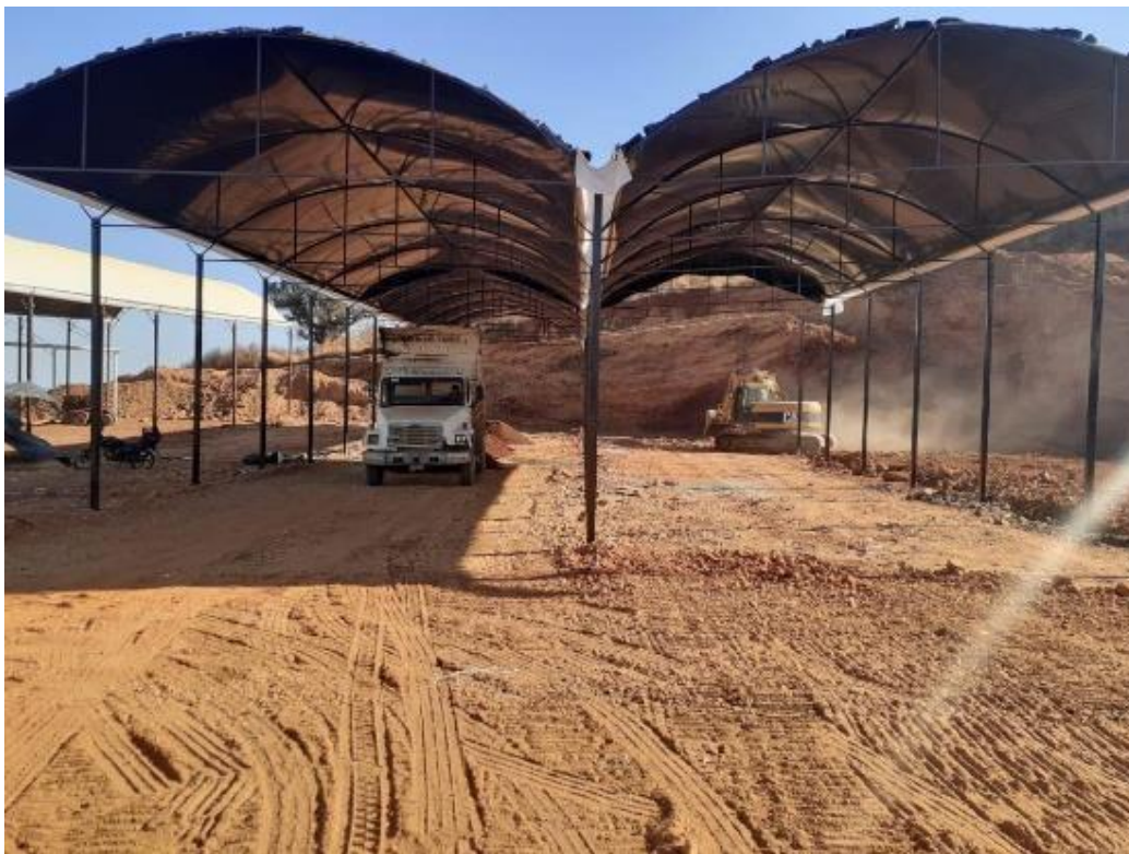
Imagen 25. Construcción de naves acondicionadas para tráileres en la Nueva Central de Abasto Villa Guerrero (Nueva Central de Abasto Villa Guerrero, 3 marzo, 2020).
