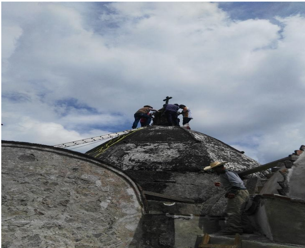
Imagen 10 trabajo de campo 2018/2019 cúpula, A.T.R
