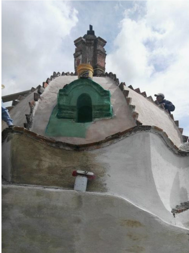
Imagen 9 trabajo de campo 2018/2019 cúpula, A.T.R
