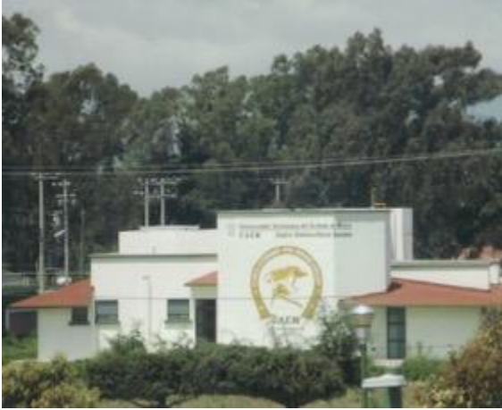
Construcción de la Clínica de Grandes Especies
