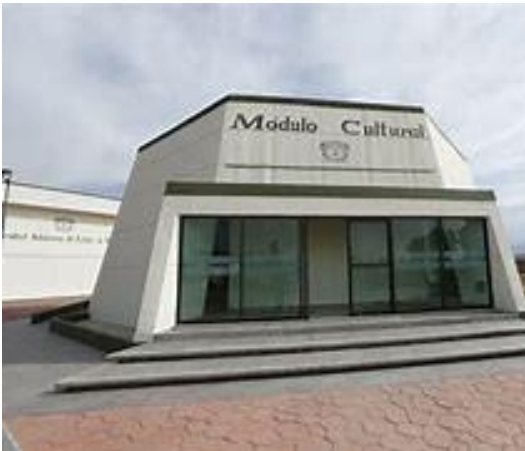
Construcción del Módulo Cultural
