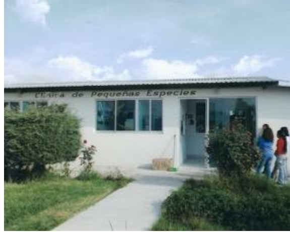
Remodelación a la Clínica de Pequeñas Especies
