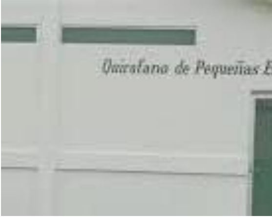
Remodelación del Quirófano
