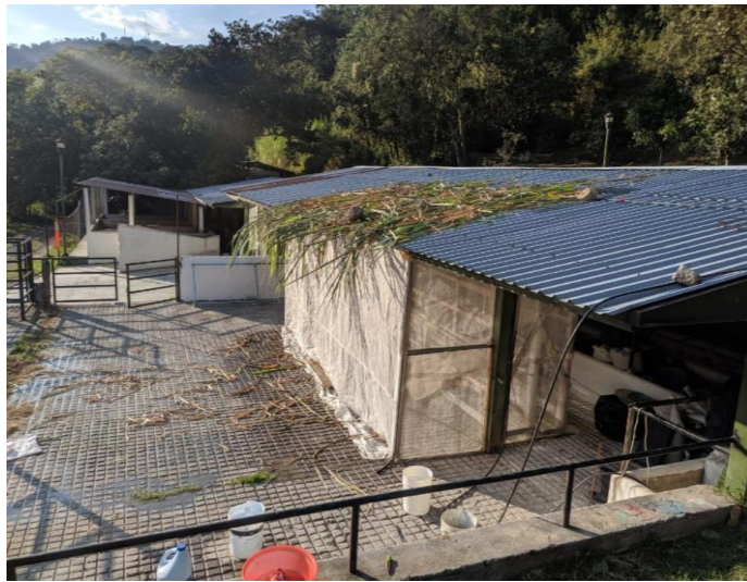
Ilustración 24: Colocación de material vegetal para disminuir el incremento de temperatura (autor propio).
