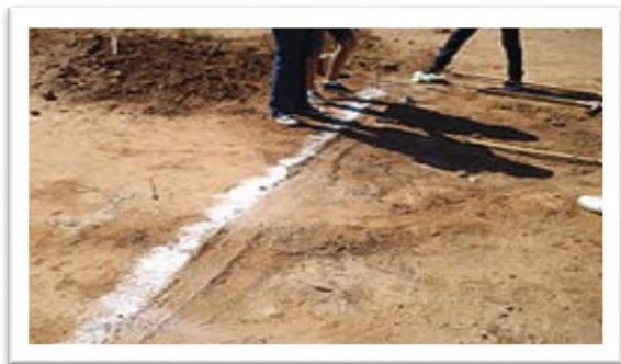
Imagen 34. Trazo de la cimentación Elaboración propia
