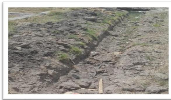
Imagen 35. Zanjas para la zapata corrida Elaboración propia
