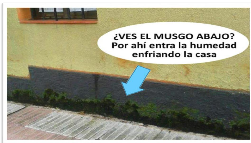
Imagen 6. Reforma Coruña. (2020). Humedades ascendentes por capilaridad del suelo - soluciones 2020 en muros y paredes. 2020, de Reforma Coruña Sitio web:
