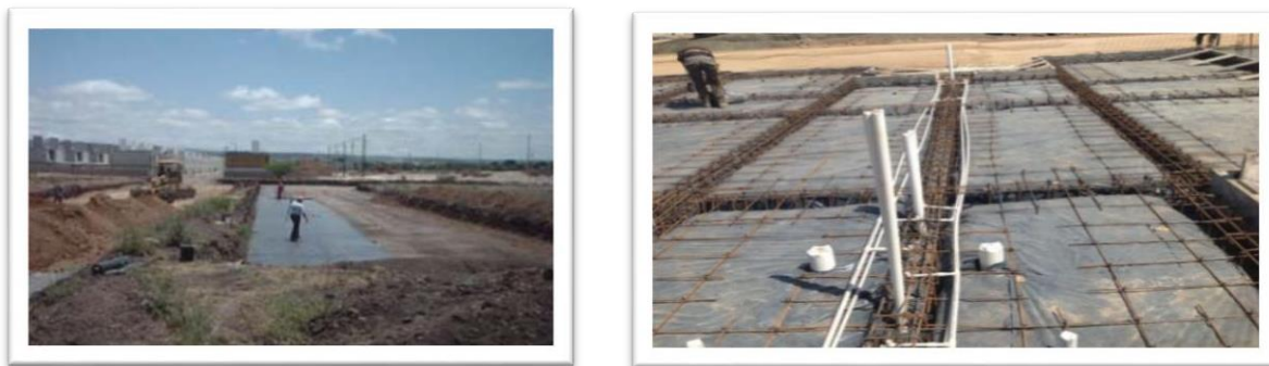
Imagen 26 y 27. Geomembrana de PVC.
