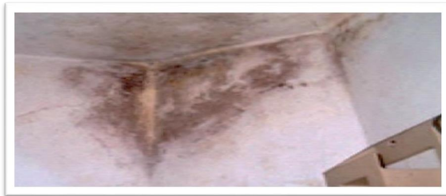
Imagen 13. Luis Humberto Casas Figueroa. (Abril 2010). Reparación de humedades.
