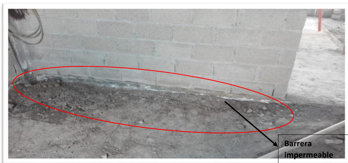
Imagen 41. Muros completos sin aplanado de la recamara secundaria.
