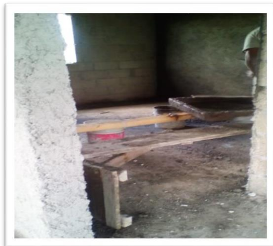
Imagen 42. Trabajos de repellado en la recamara secundaria provisional.
