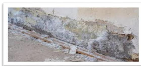
Imagen 16 y 17. Humedad por capilaridad. Reparación de patologías Sitio web:
