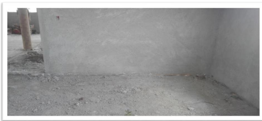
Imagen 39. Muros completos con aplanado de la recamara principal.
