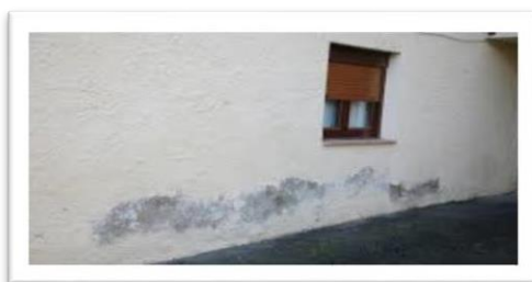
Imagen 16 y 17. Humedad por capilaridad. Reparación de patologías Sitio web:
