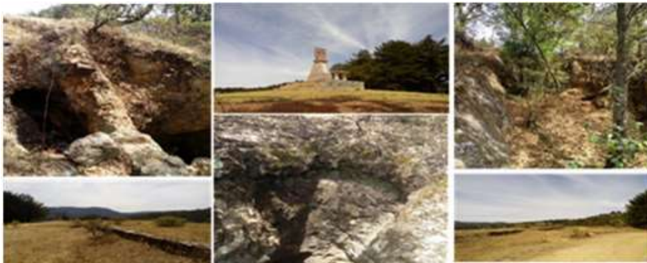
Figura 7. Conjunto de fotografías. Socavón en el Cerrito Lacolot.
