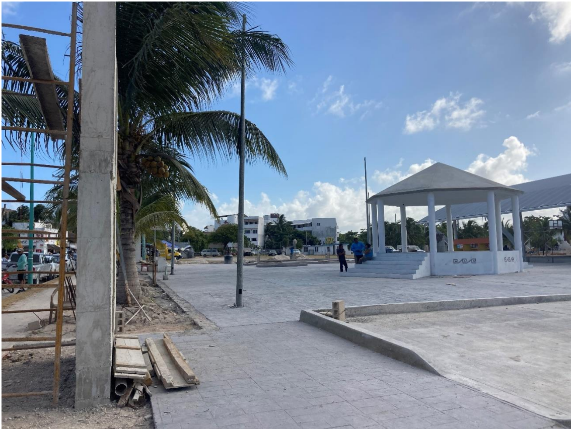
Construcción del Kiosco central de la localidad.
