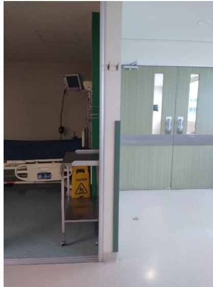
Figura 27. Pared de Tablaroca entre Cubículo 1 y entrada del área de Cuidados Intensivos (Capturada por el autor).
