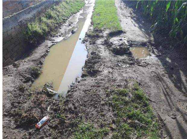
Figura 4.29. *Fuga en la red de drenaje*
