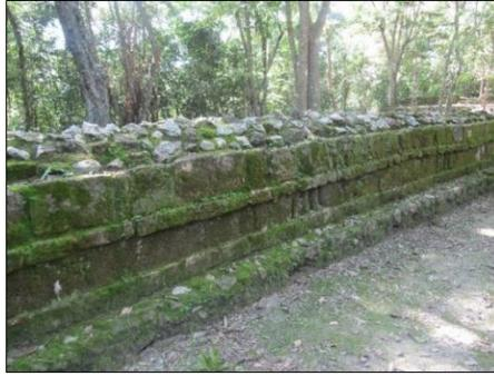
Fig. 142. Muro norte de la plataforma 4H1 con molduras y tamborcillos Río Bec. (Espinoza, 2019).
