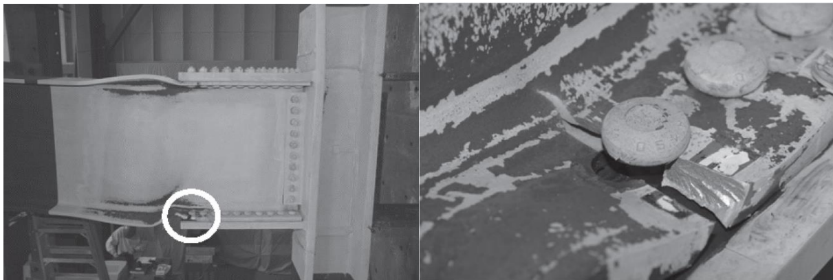
Figura 2-9. Fractura en conexión BFP-3 al final de la prueba (Sato et al. 2008)
