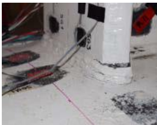
Figura 4-8. Fractura en metal base en conexión de cubreplaca en IBI (Perea et al. 2019)
