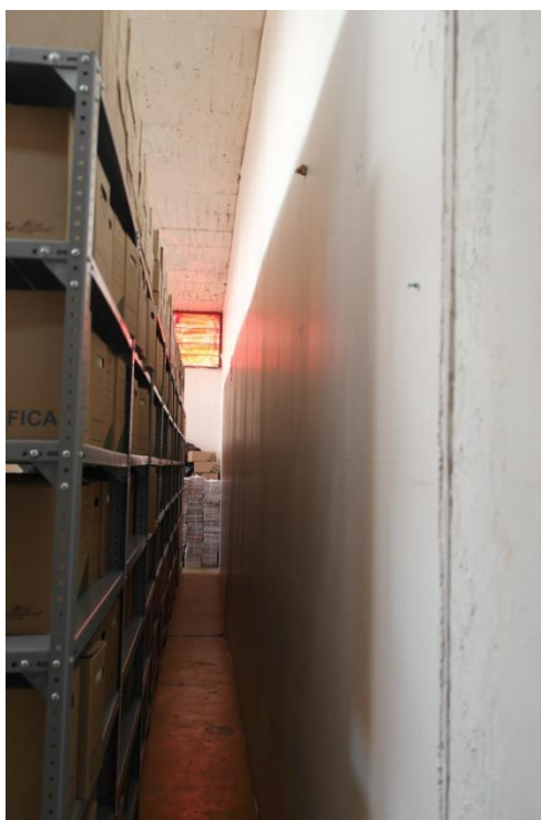
Ilustración 56: Muro de tabla roca dentro del archivo
