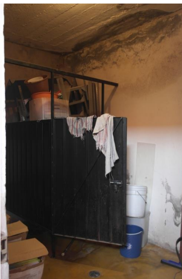
Ilustración 59: Condiciones del baño para el personal del archivo
