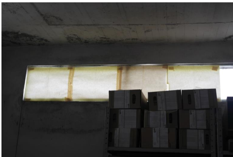
Ilustración 55: Ventilación dentro del archivo municipal
