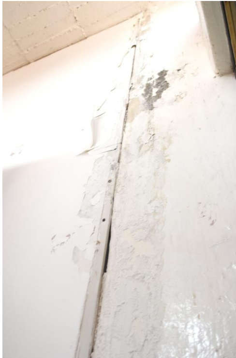
Ilustración 57: Desprendimiento del muro que divide al archivo de las oficinas de bomberos
