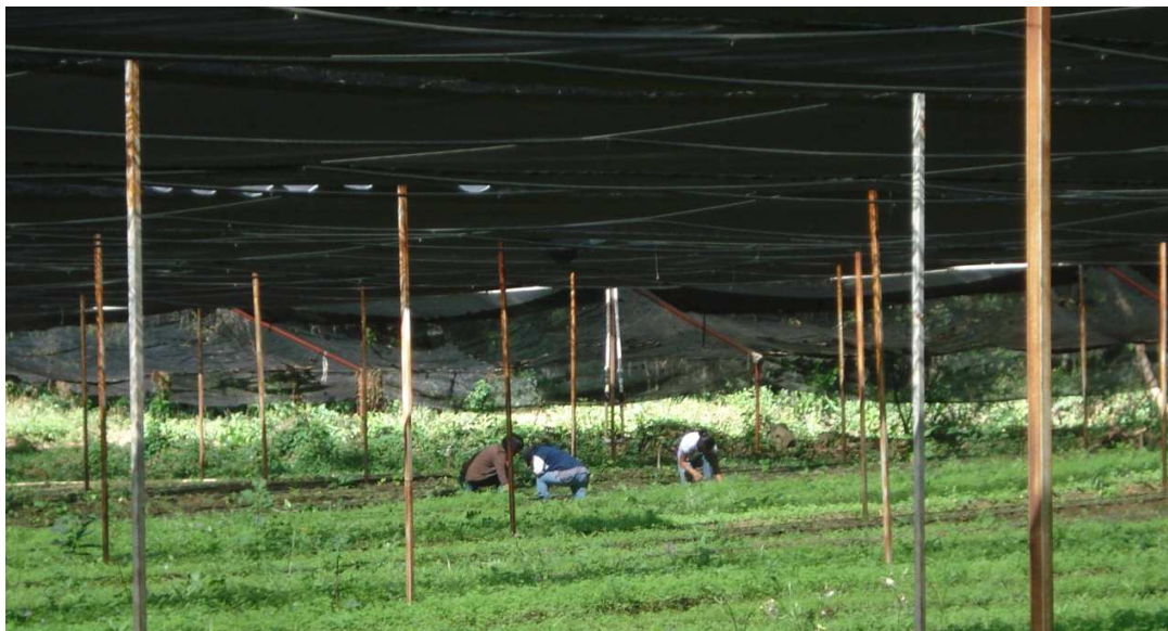
Figura 51. Infraestructura para floricultura con malla sombra y desyerbe del terreno
