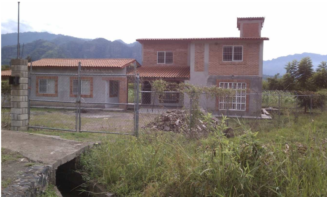
Figura 77. Recién construcción de casa
