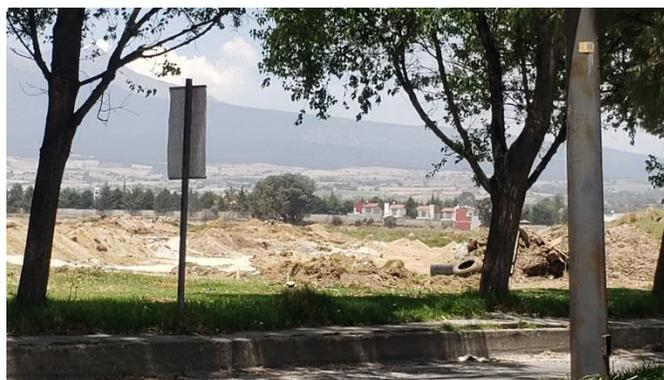
Figura 31. Despalme de capa de suelo para iniciar con el proceso de construcciones urbanas. Fuente: trabajo de campo.
