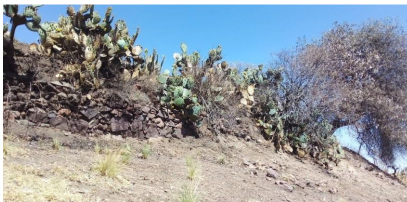
Figura 36. Terraza no. 13 con muro de roca y tierra en la ladera sur del Cerro Tlacotepec.
