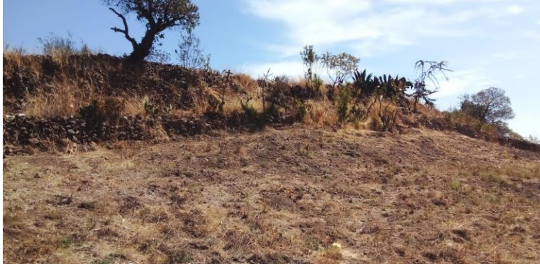
Figura 27. Extensión de la terraza no. 10 con muro de roca en la ladera sur.
