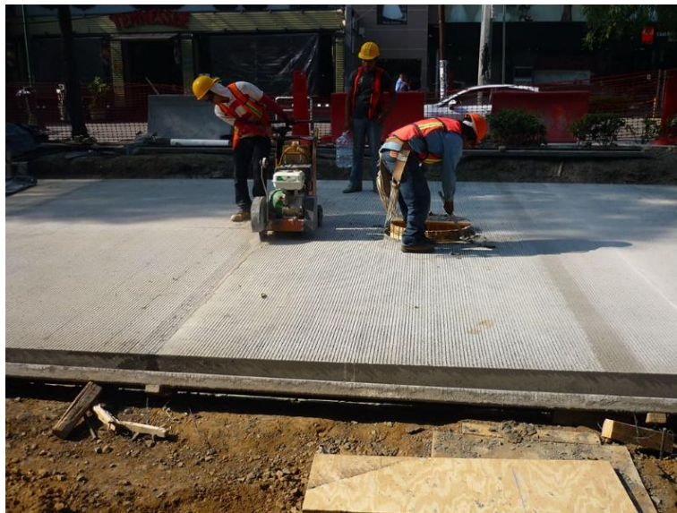
Imagen 13 “Trabajos en Avenida Presidente Masaryk”
