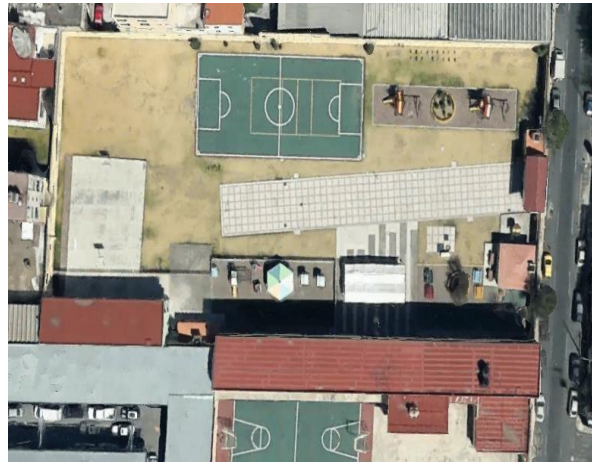
IMAGEN 16. Instalaciones kínder y primaria UIFT
