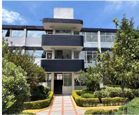
IMAGEN 24. Fachada lateral Edificio Norte Fac.
