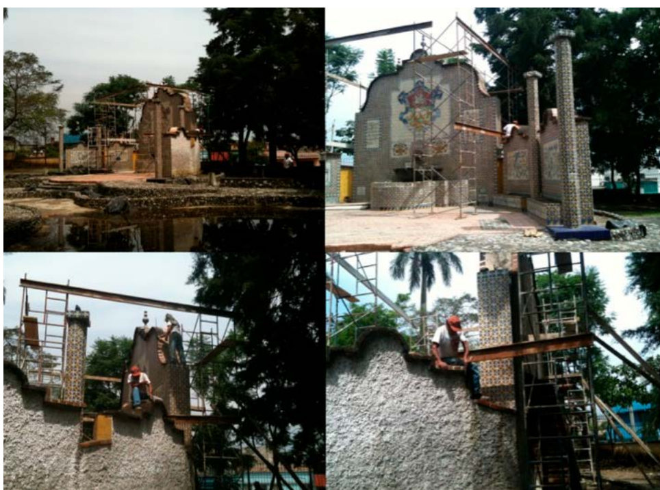
Figura 4. Trabajos de restauración de la Plaza México Fuente: Bonilla (2011).
