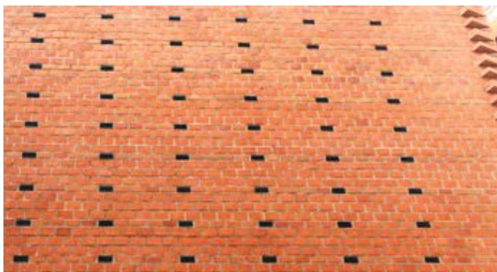
Fotografía 4. Configuración reticulada de ladrillos macizos de vidrio
