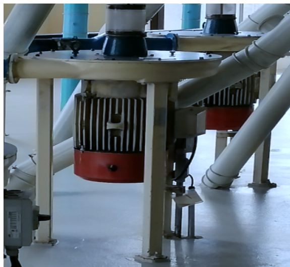
Figura 2. Motores ubicados en el sótano Fotografía tomada por el sustentante
